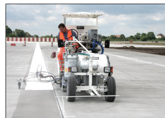
H26 bei Airbus in Hamburg/Deutschland ausgerüstet mit 1K-Kaltfarben Airless sowie 2K-Kaltspritzplastiken Airless System M98:2, 460 ltr Druckbehälter sowie 90 cm Breitstrichmarkeur mit 3 Farbpistolen
