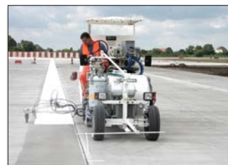
H26 en el terreno de la compañía Airbus, Hamburgo / Alemania equipada con sistema de pinturas en frío de 1-componente Airless así como pinturas plásticas en frío pulverizables de 2-componentes Airless M98:2, 460 l depósito presurizado así como marcador aeroportuario de 90 cm y 3 pistolas de pintura
