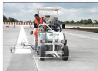
H26 bei Airbus in Hamburg/Deutschland ausgerüstet mit 1K-Kaltfarben Airless sowie 2K-Kaltspritzplastiken Airless System M98:2, 460 ltr Druckbehälter sowie 90 cm Breitstrichmarkeur mit 3 Farbpistolen
