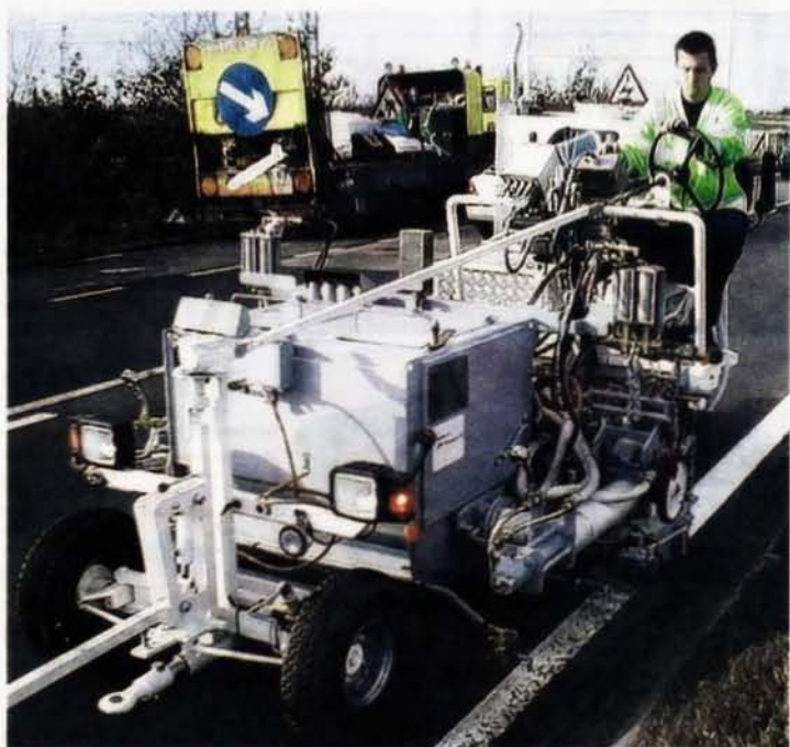
Ab 14.15 Uhr folgt der praktische Teil: Neueste Entwicklungen von Markierungsmaschinen werden auf dem Gelände an der Industriestraße vorgeführt.
