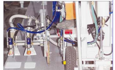
Eine Straßenmarkierung wird gesetzt.
