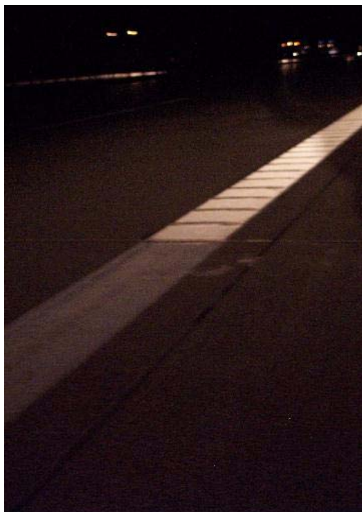
Ганновера 13,5 км Переход края разметки Краска/ КП поперечное профилирование 90° на ВAB A 2 ночью, дорожное полотно в направлении Ганновера 15,3 км
