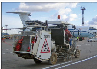
H26 в Санкт-Петербурге, Россия с 1К-холодными красками, а также с 2К-холодным спрей-пластиком, система airless 98:2, 460-литровый быллон под давлением для работы с пистолетом для краски или 2К-спрей-пистолетом на рулежных дорожках.
