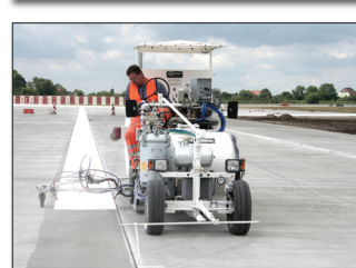
H26 в Санкт-Петербурге, Россия с 1К-холодными красками, а также с 2К-холодным спрей-пластиком, система airless 98:2, 460-литровый быллон под давлением для работы с пистолетом для краски или 2К-спрей-пистолетом на рулежных дорожках.
