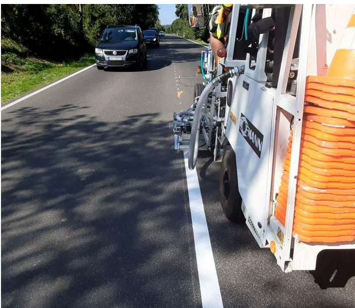
С новой поворотной системой маркировочная машина особенно гибкая в эксплуатации.
