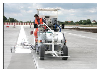
H26 bei Airbus in Hamburg/Deutschland ausgerüstet mit 1K-Kaltfarben Airless sowie 2K-Kaltspritzplastiken Airless System M98:2, 460 ltr Druckbehälter sowie 90 cm Breitstrichmarkeur mit 3 Farbpistolen
