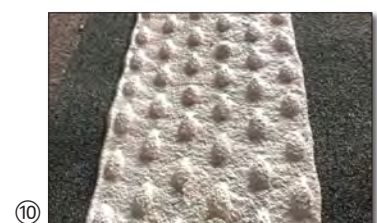
MultiDotLine®Plus Markierung, Profil auf Glattstrich in einem Arbeitsgang markiert.
